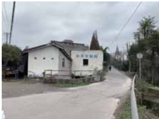
渠道整治终点
