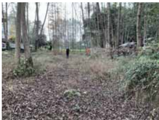
施工道路恢复
