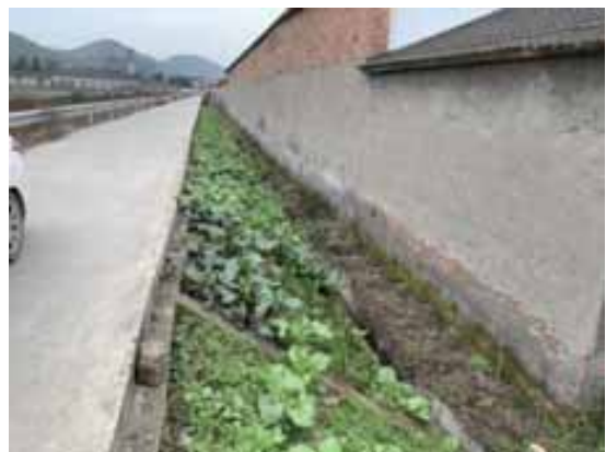
维修养护通道护坡
