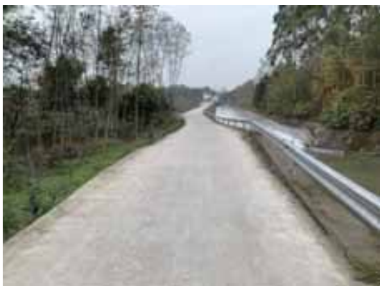
维修养护通道
