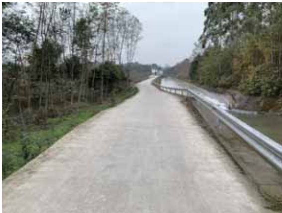
维修养护通道
