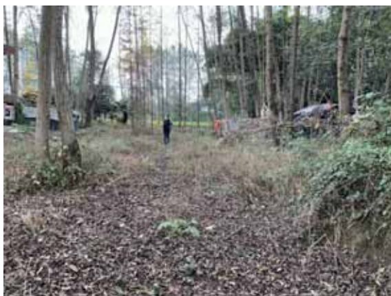
施工道路恢复
