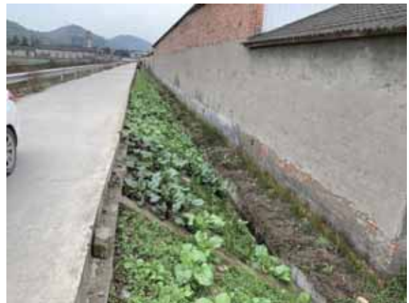
维修养护通道护坡
