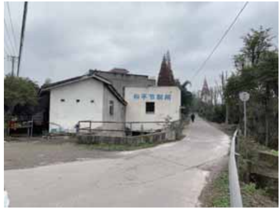
渠道整治终点
