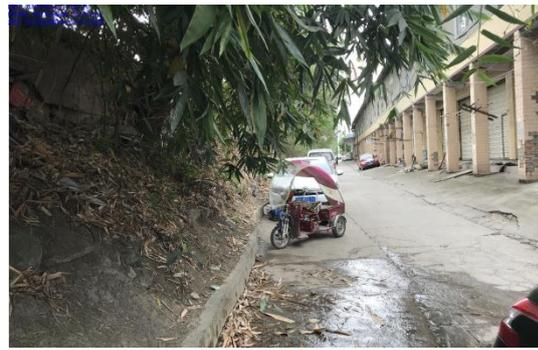
图 2.2-2 油分厂填方渠渗漏
