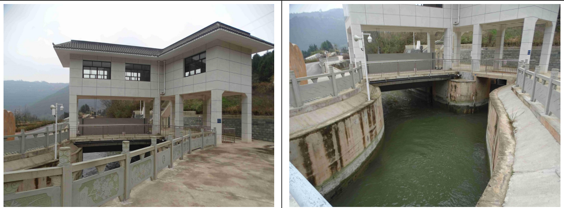
节制闸、进水闸枢纽
