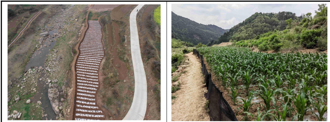
隧洞出口至 3#渣场道路（已复耕）
