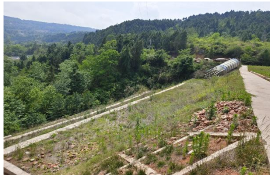
1#渣场框格梁植草护坡
