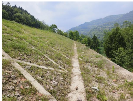
2#渣场框格梁植草护坡
