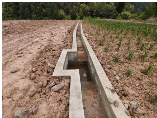
3#渣场排水沟与沉沙池
