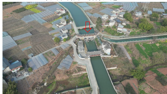
罗家河坝枢纽闸（拆除重建）
