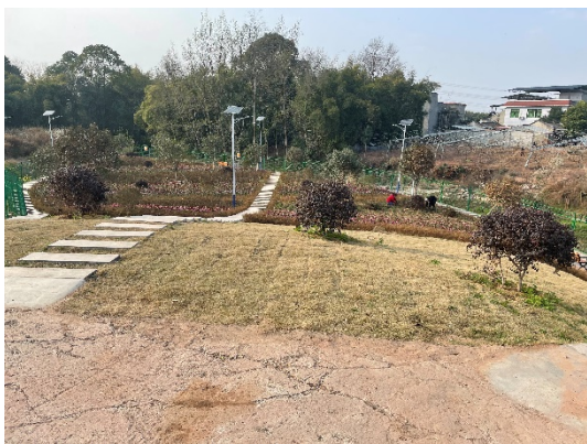
9#施工工区现状
