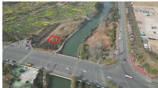
8#施工工区（东风渠 K40+990 右）
