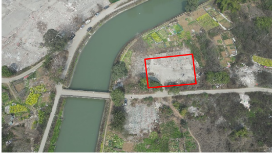
3#施工工区（东风渠 K8+900 右）
