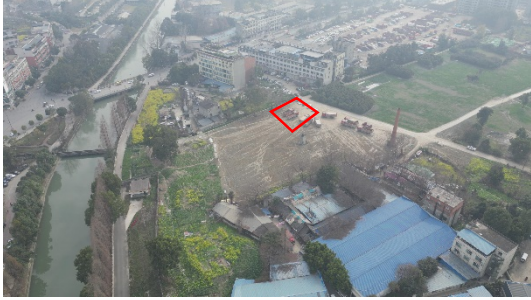
1#施工工区（东风渠 K0+450 右）
