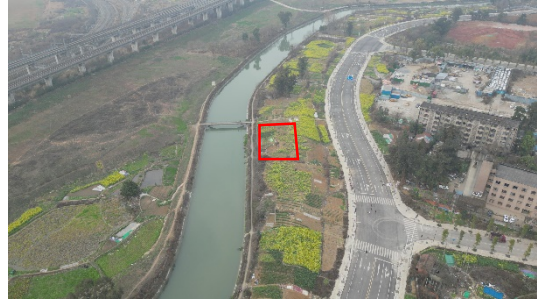
4#施工工区（东风渠 K19+860 左）
