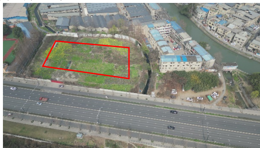
2#临时堆土场（东风渠 K5+500 右）
