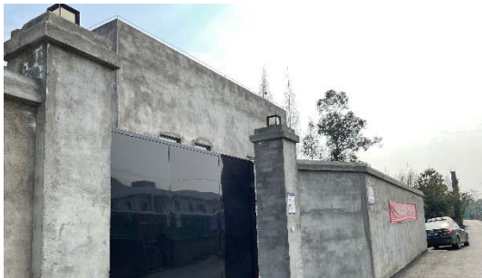
新都大丰水厂泵站
