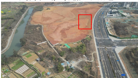
7#临时堆土场（东风渠 K37+000 右）
