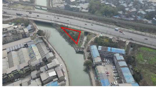
2#施工工区（东风渠 K5+600 右）
