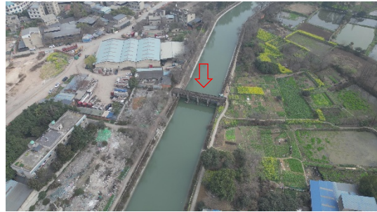
东风节制闸（拆除重建）
