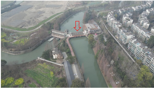
东风渠进水闸（拆除重建）
