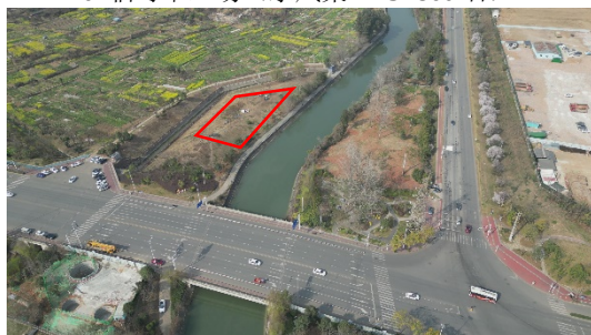
8#临时堆土场（东风渠 K40+940 右）
