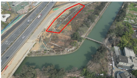
5#临时堆土场（东风渠 K23+600 左）
