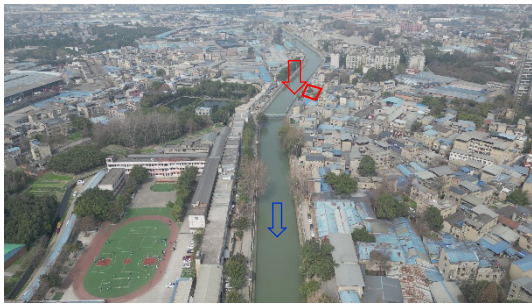
新都大丰水厂取水口及泵站
