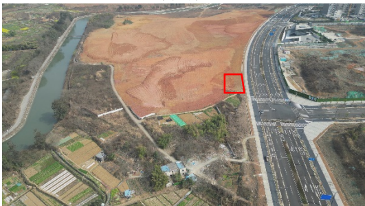
7#施工工区（东风渠 K36+930 右）
