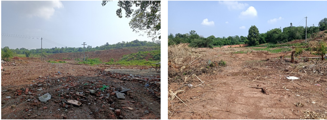
成都市环城生态区土地综合整治与生态修复项目施工（一批次）三标段工程现状
