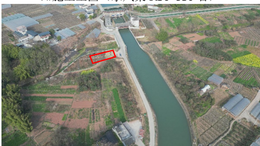
9#施工工区（罗家河坝枢纽闸西南右）
