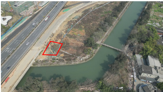
5#施工工区（东风渠 K23+450 左）
