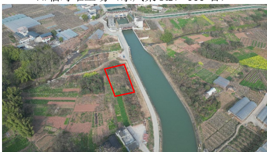
9#临时堆土场（罗家河坝枢纽闸西南右）
