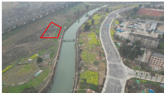
4#临时堆土场（东风渠 K19+820 右）
