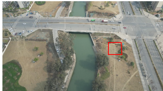
6#施工工区（东风渠 K25+910 右）
