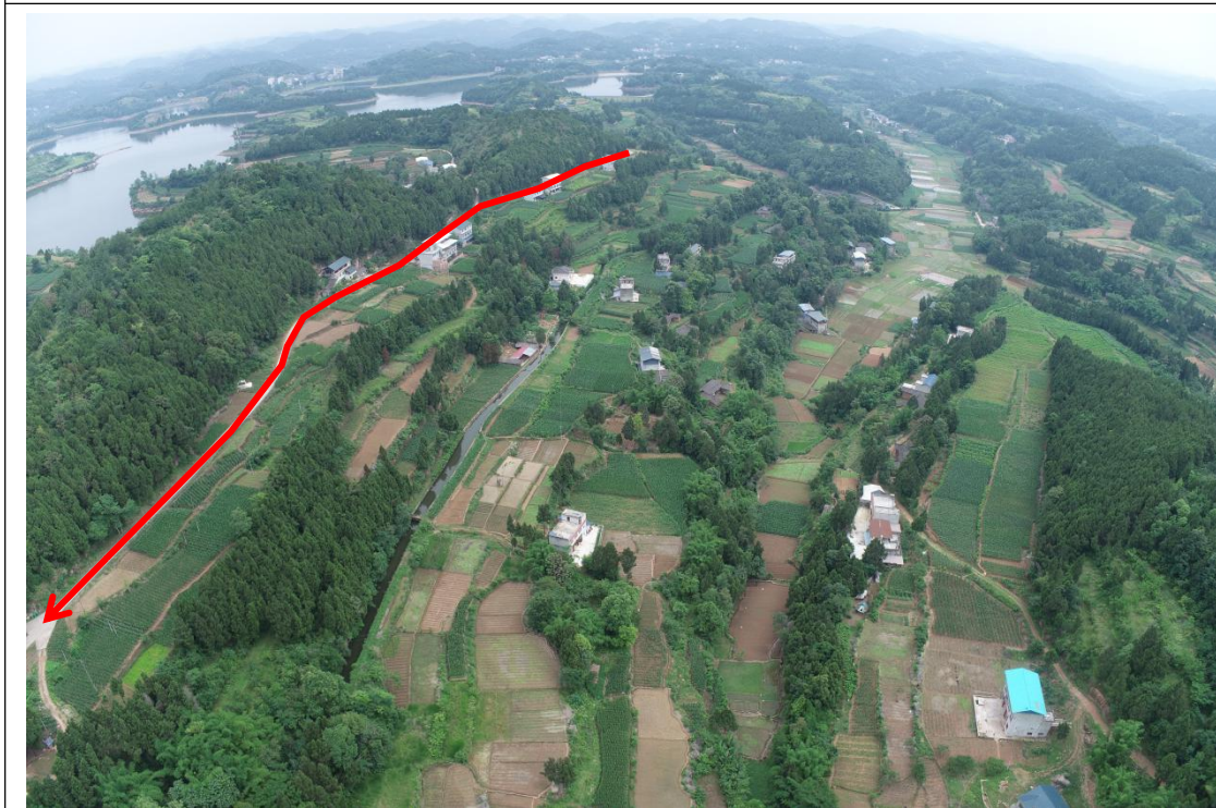
防汛抢险道路
