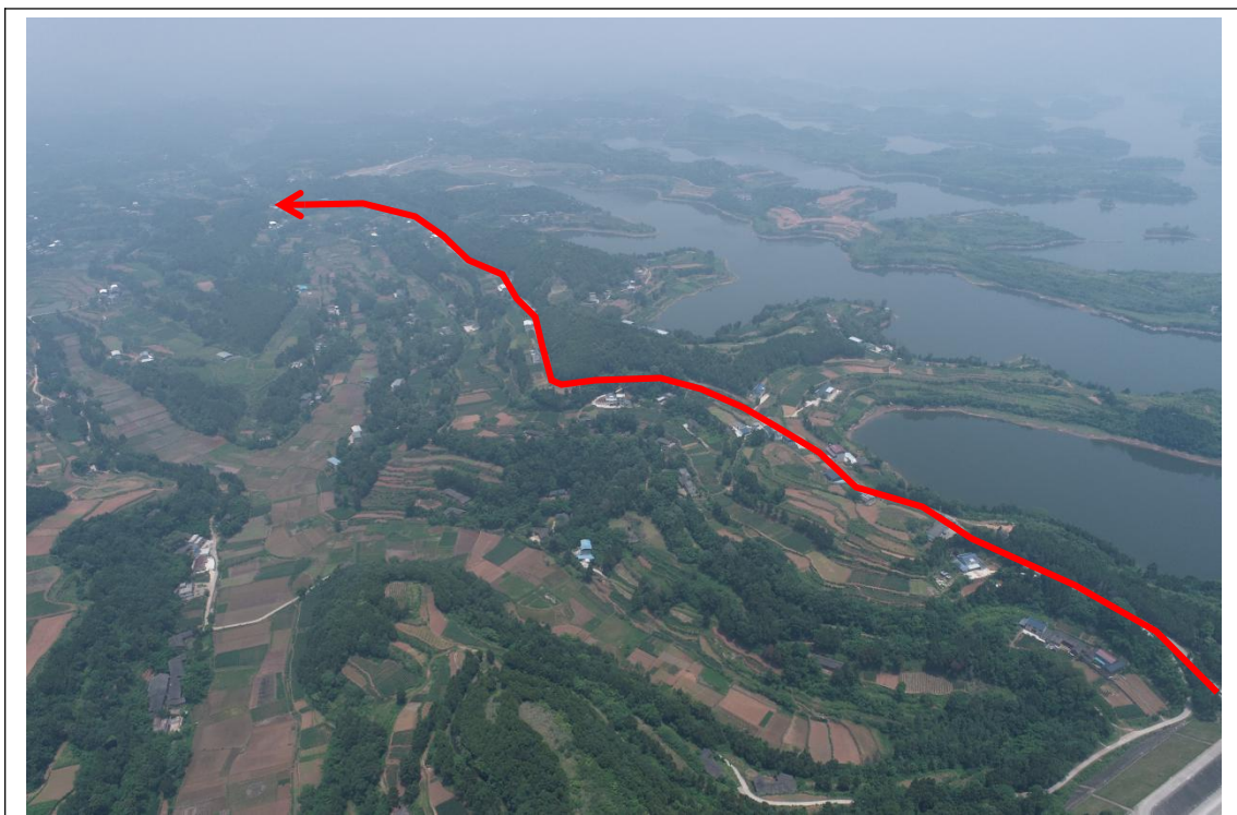
防汛抢险道路
