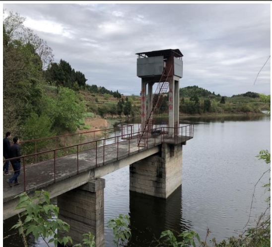
鲁西放水隧洞进口
