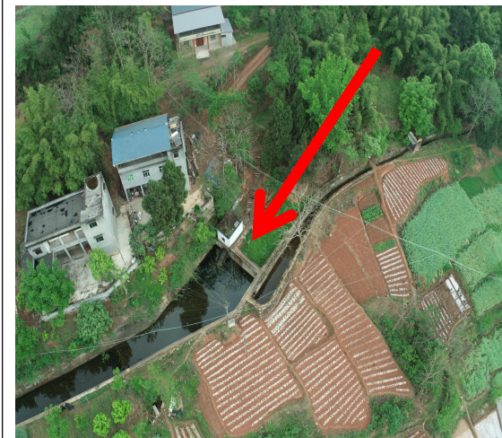
鲁西放水隧洞出口
