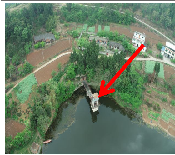
鲁西放水隧洞进口
